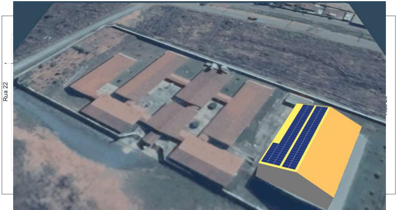
FIGURA 3 – ÁREA SUGERIDA PARA INSTALAÇÃO DO SISTEMA FV.
