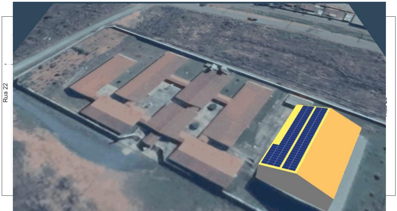
FIGURA 3 – ÁREA SUGERIDA PARA INSTALAÇÃO DO SISTEMA FV.
