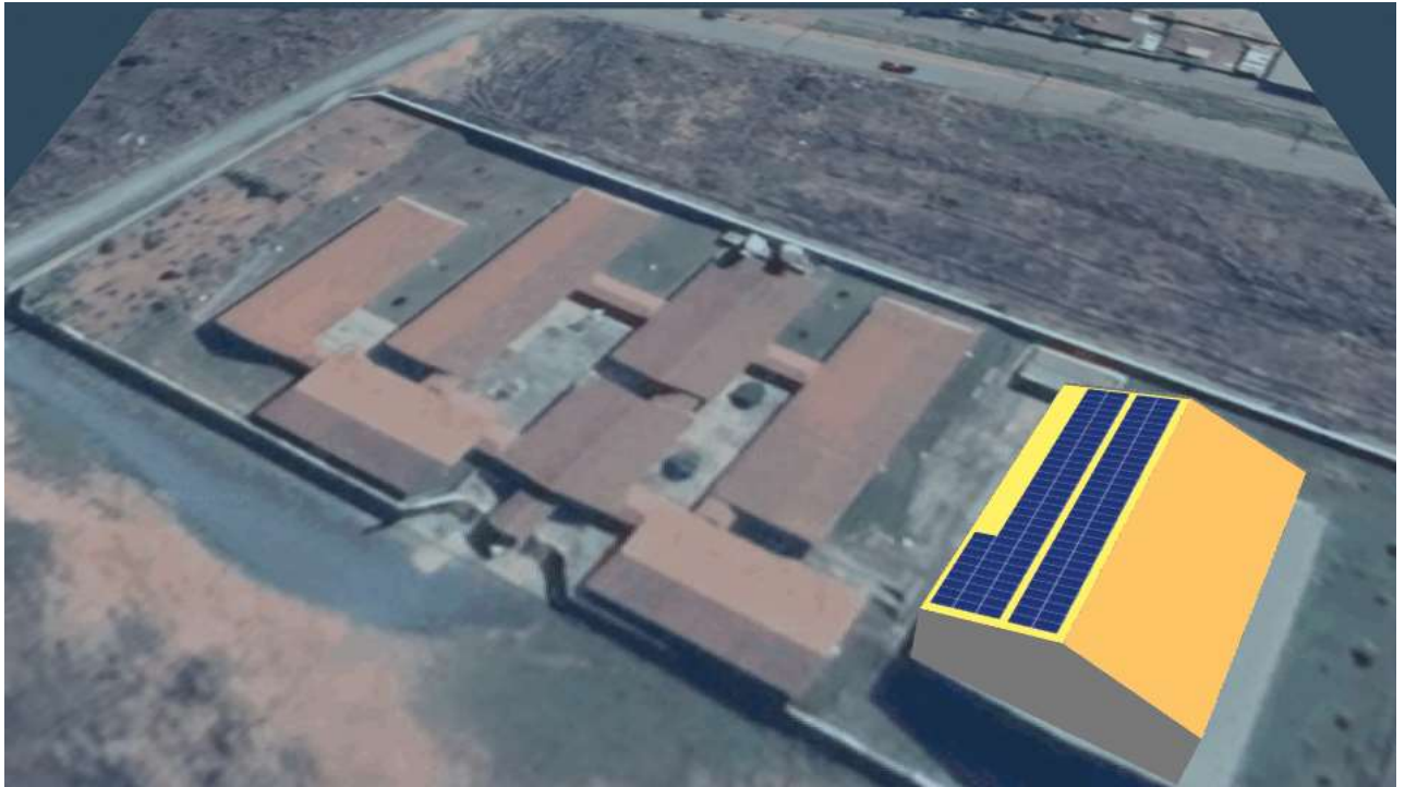
FIGURA 2 – ÁREA SUGERIDA PARA INSTALAÇÃO DO SISTEMA FV.
