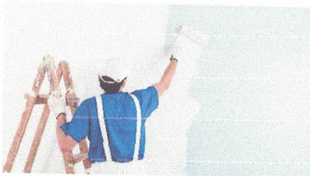
Mão de Obra da Pintura.
